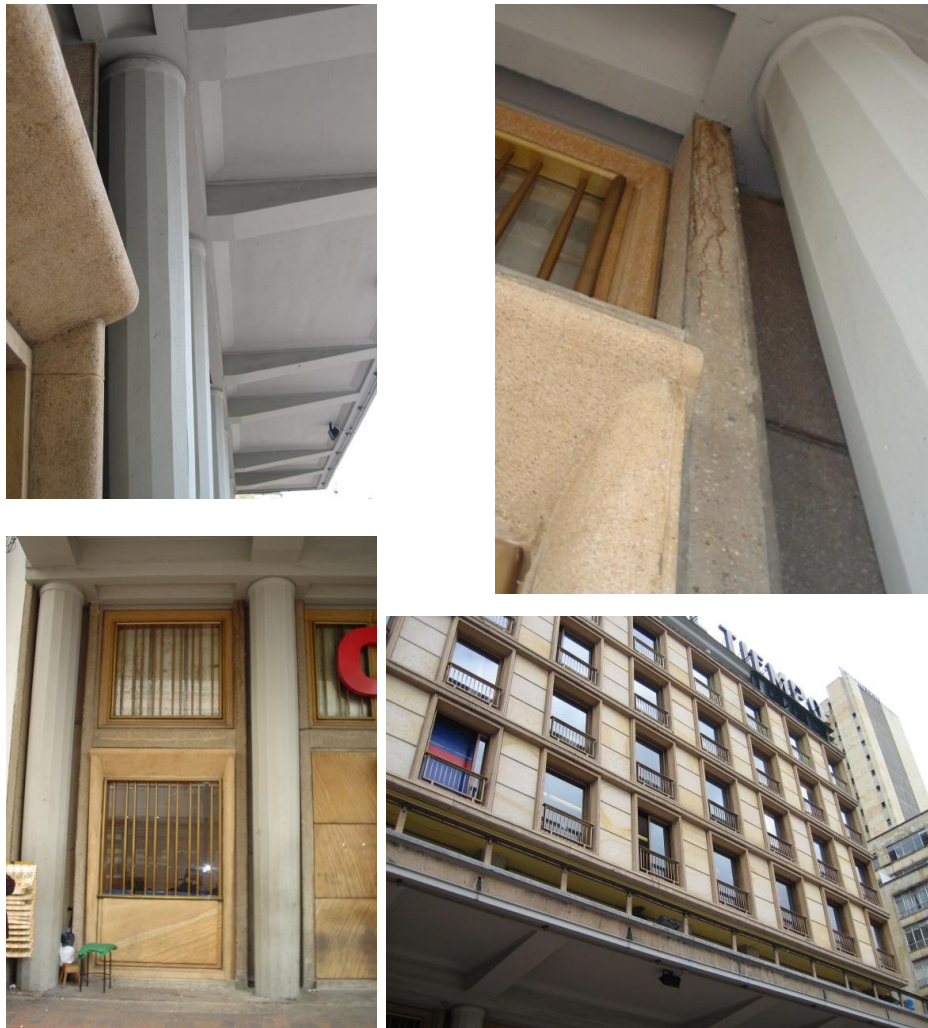
Figura 6. Dettagli parziali de Fachada.
