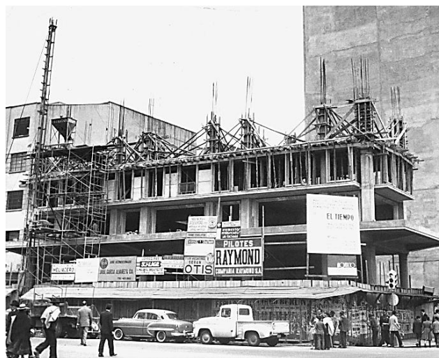
Figura 3. Sistema constructivo y elementos prefabricados. Fuente: Archivo de Bogotá. Fondo Documental. Arquitectos e Ingenieros.
